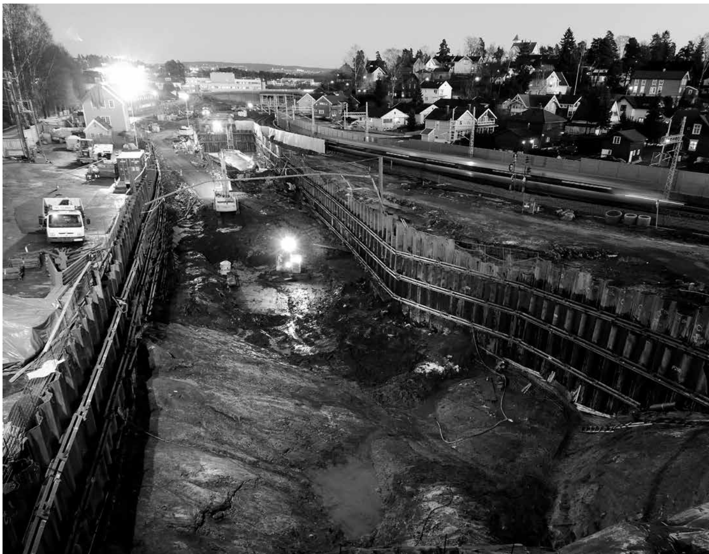
Foto: Jernbaneverket/Hilde Lillejord
