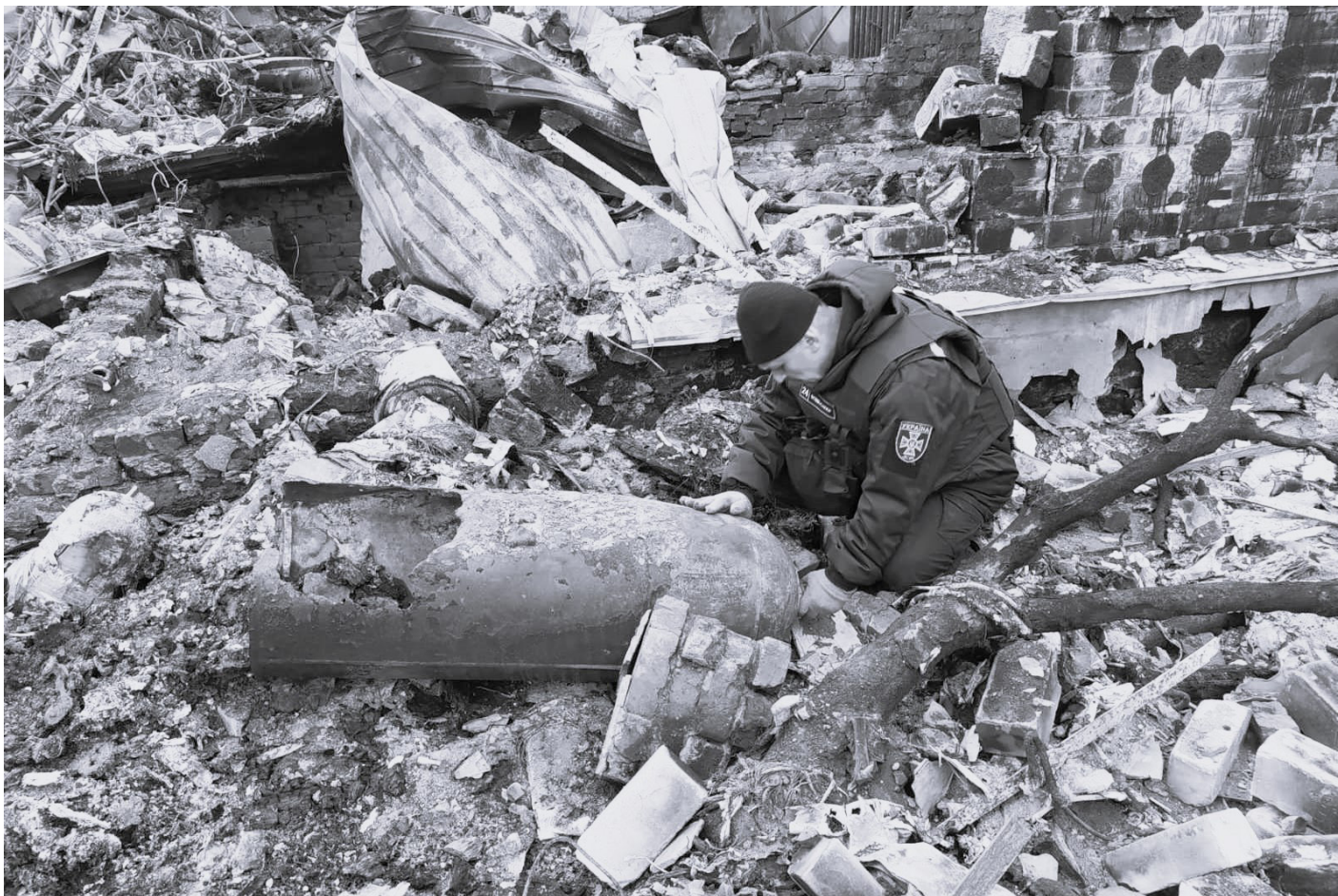
Ødelagt bygning etter russiske bombenedslag i Ukraina i 2022. Foto fra State Emergency Service of Ukraine. CC4.0.
